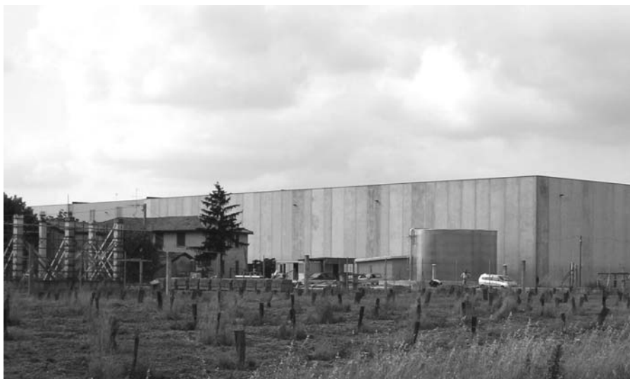
L'Interporto durante i lavori di ampliamento
