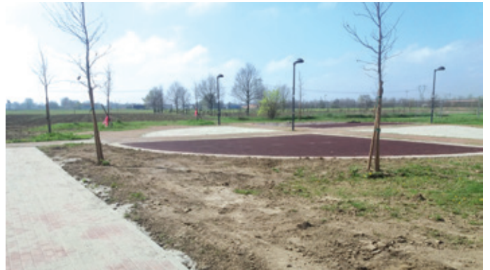
Parco Corte San Giusto, camminamenti in fase di ultimazione lavori
