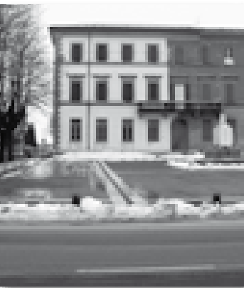
Il Palazzo della posta
